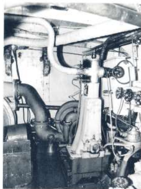
Den ångdrivna cirkulationspumpen i omålat skick gjord av Gårda Verkstad. Foto: B.S.
